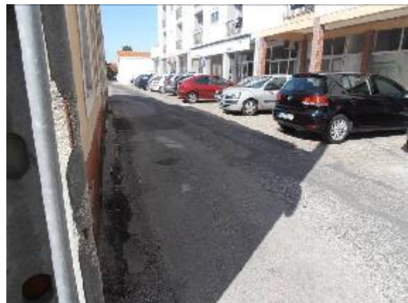
Foto 2 – Travessa Vieira de Leiria – Vista do entroncamento com a rua da Alegria
