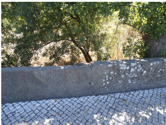
Ilustração 5: Muro de Norberto Barroca
