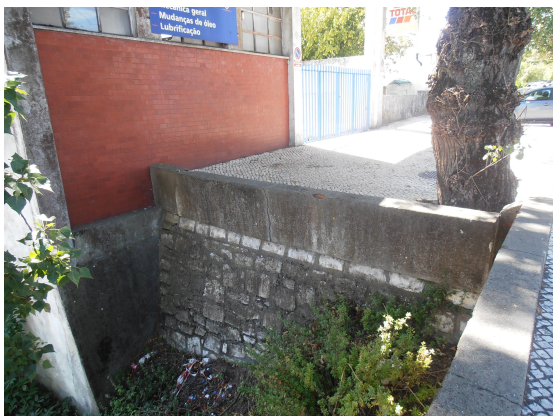
Ilustração 3: Muro da vala
