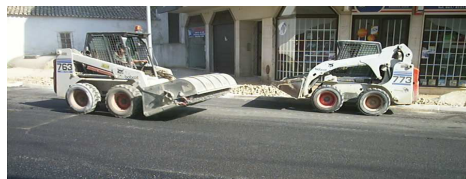
Limpeza do Pavimento
