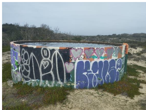
Fig. 7 - Reservatório do Samouco
