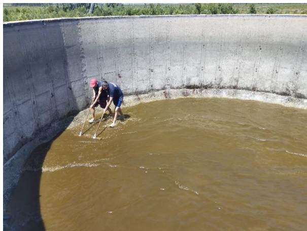
Fig. 10 - Intervenção no ponto de água do Tremelgo
