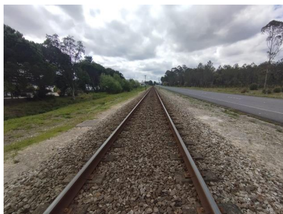
Fig. 15 - Intervenção na FGC junto da rede ferroviária
