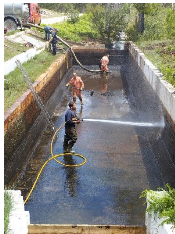
Fig. 11 - Intervenção no ponto de água da Formosa
