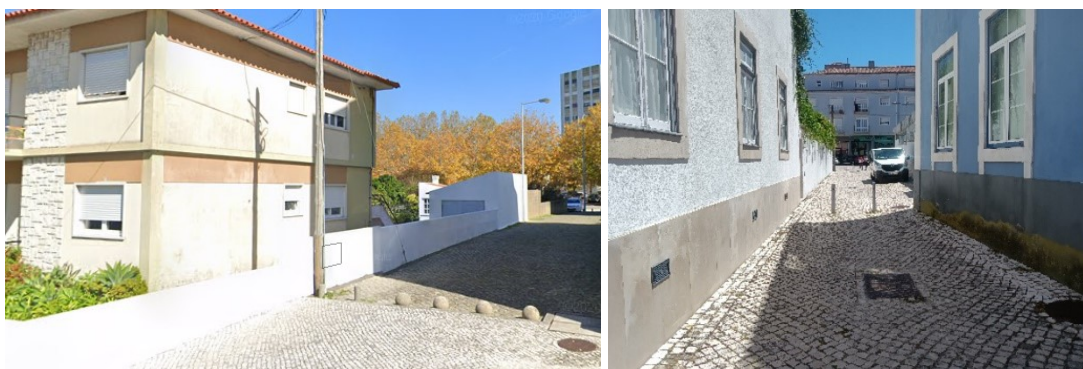
Figura 51. Eixos predominantemente pedonais com barreiras físicas
