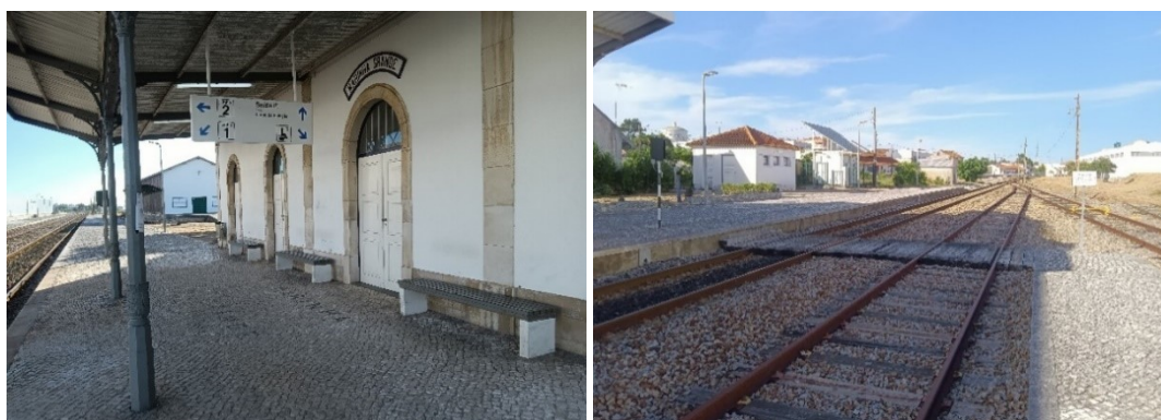
Figura 84. Características infraestruturais das plataformas de embarque da Estação Ferroviária da Marinha Grande e acesso pedonal entre ambas
