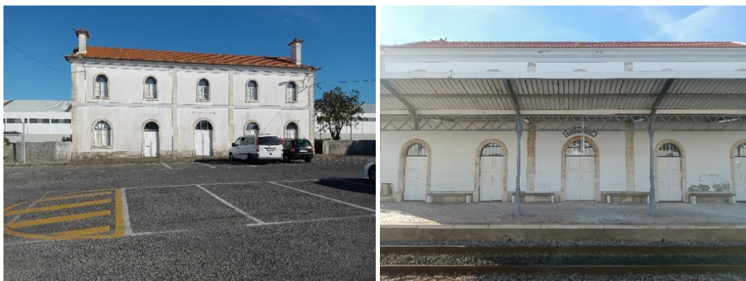
Figura 81. Estação Ferroviária da Marinha Grande
