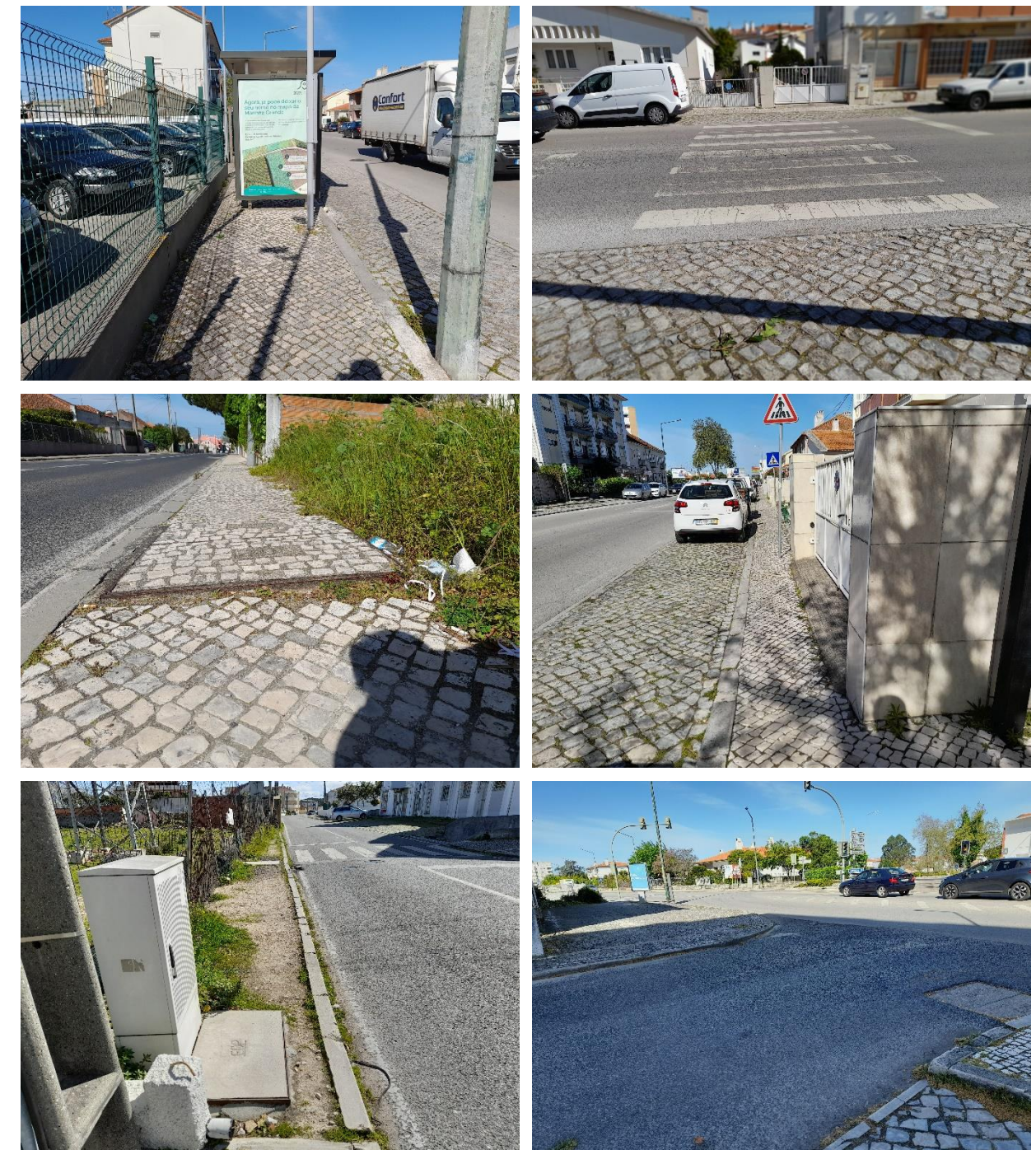
Figura 13. Exemplos de barreiras identificadas na área de estudo do Plano de Promoção da Acessibilidade em Espaço Público da Cidade de Marinha Grande Fonte: mpt®, 2022
