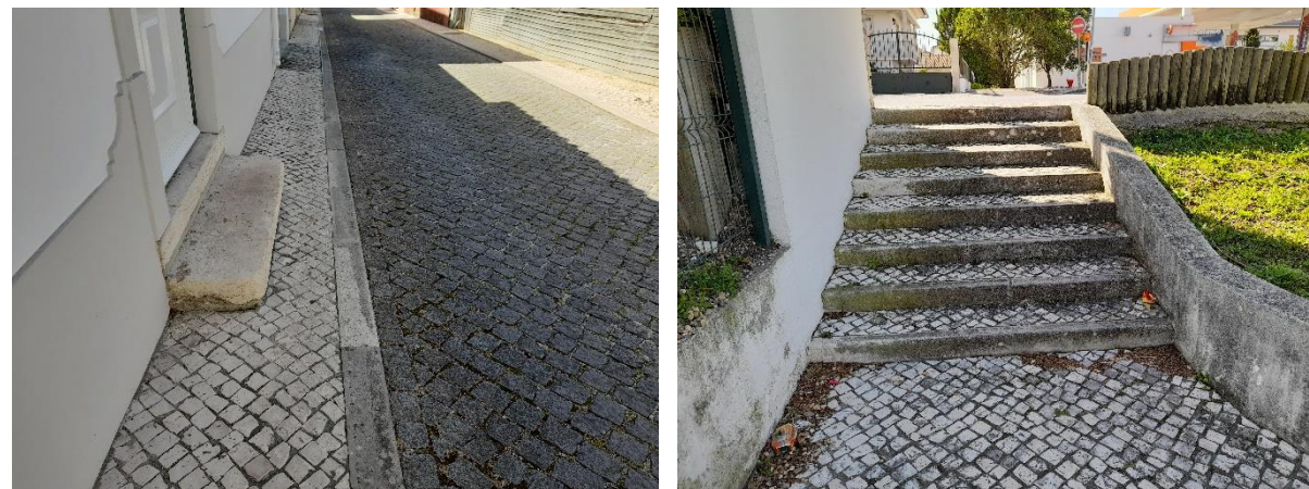
Figura 29. Exemplos de degrau a obstruir o percurso pedonal (esquerda) e escadas não regulamentares (direita) na área de estudo Fonte: mpt®, 2022
