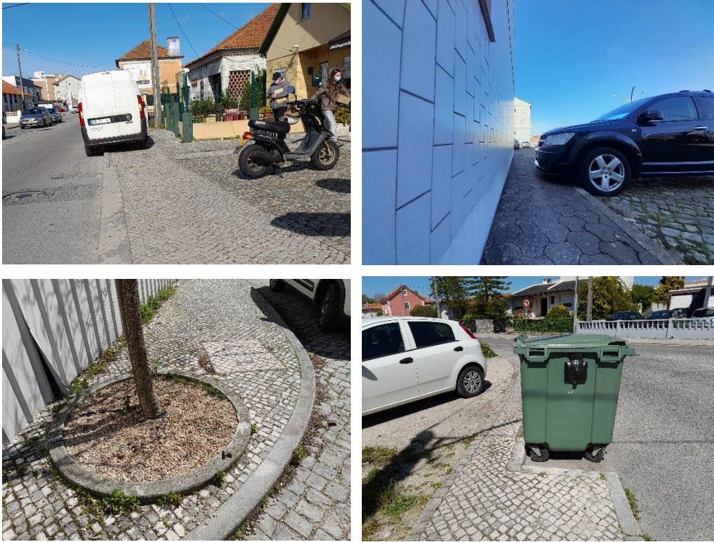
Figura 7. Exemplos de barreiras com influência na largura livre no canal de circulação (1/2)
