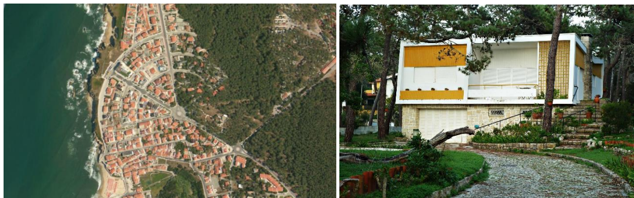
Foto 25 – Edifício Habitacional - Núcleo de urbano da povoação de São Pedro de Moel
