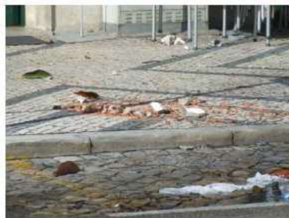
Figura 14 - Queda de chaminé de bloco habitacional para a via pública, por ação de vento e chuvas fortes (janeiro de 2009)
