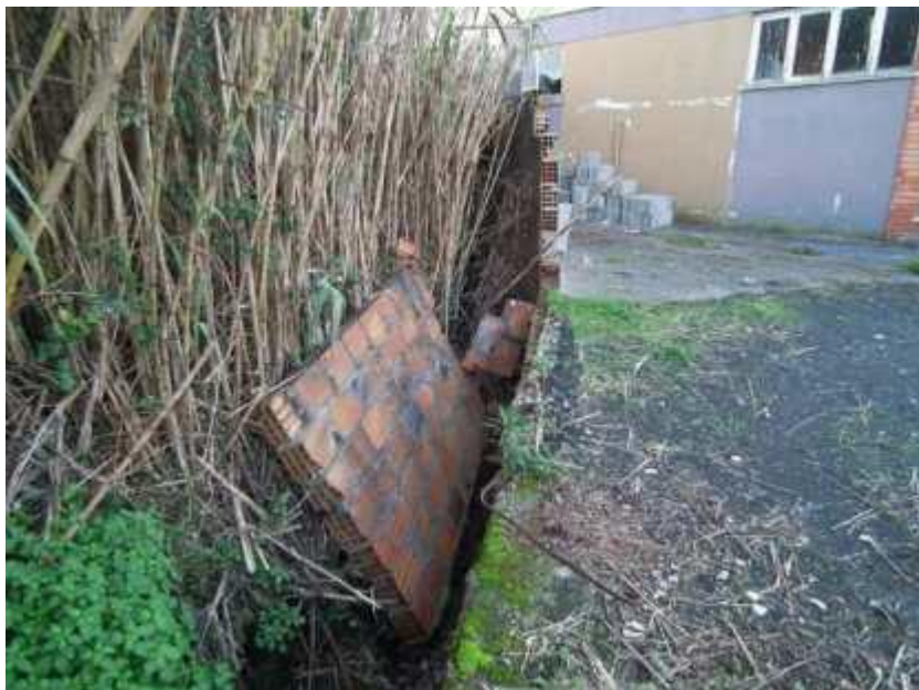
Figura 6 - Ponto de controlo n.º 11 - Ribeira Valdreanes – Rua da Portela, Portela
